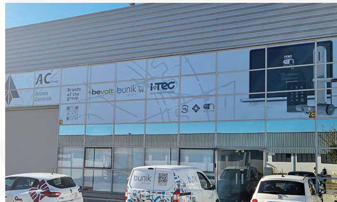
Fachada | Façade | Fachada | Façade
