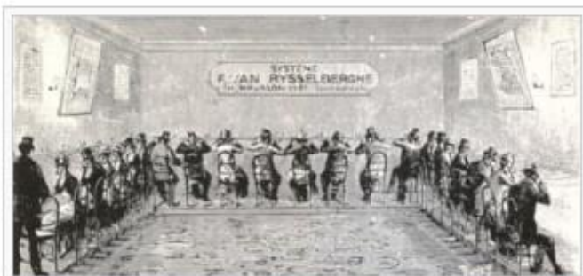
Het "systeem Van Rysselberghe", gedemonstreerd tijdens de Wereldtentoonstelling van 1885 in Antwerpen. Bezoekers konden via telefonie een concert beluisteren dat tezelfdertijd in Brussel werd uitgevoerd.
