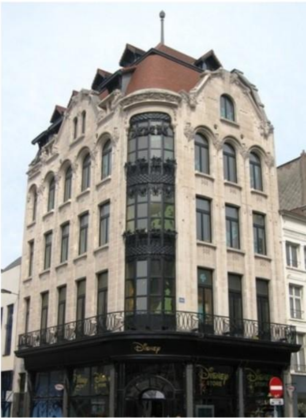
Hoekgebouw Meir-lange Klarenstraat in art nouveau
