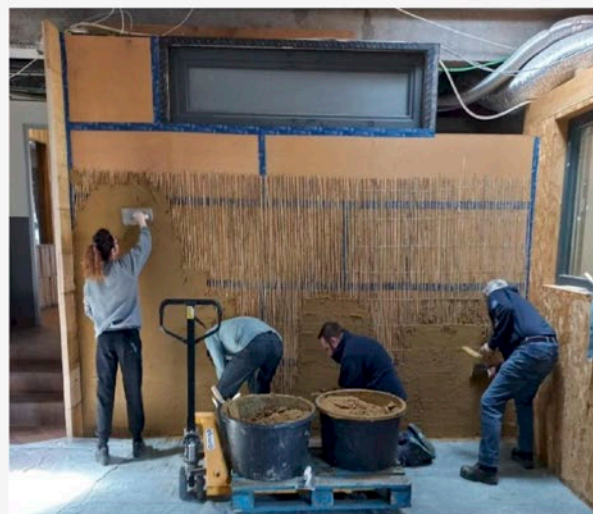
Een opleiding kleipleisterwerk
