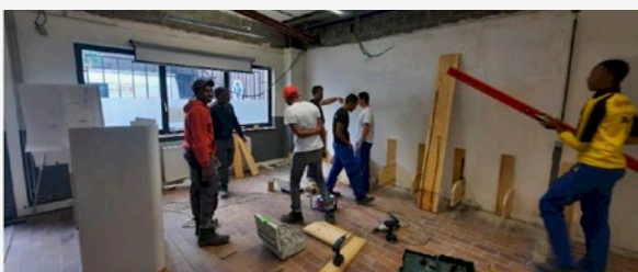
La réalisation de banquettes de réemploi
